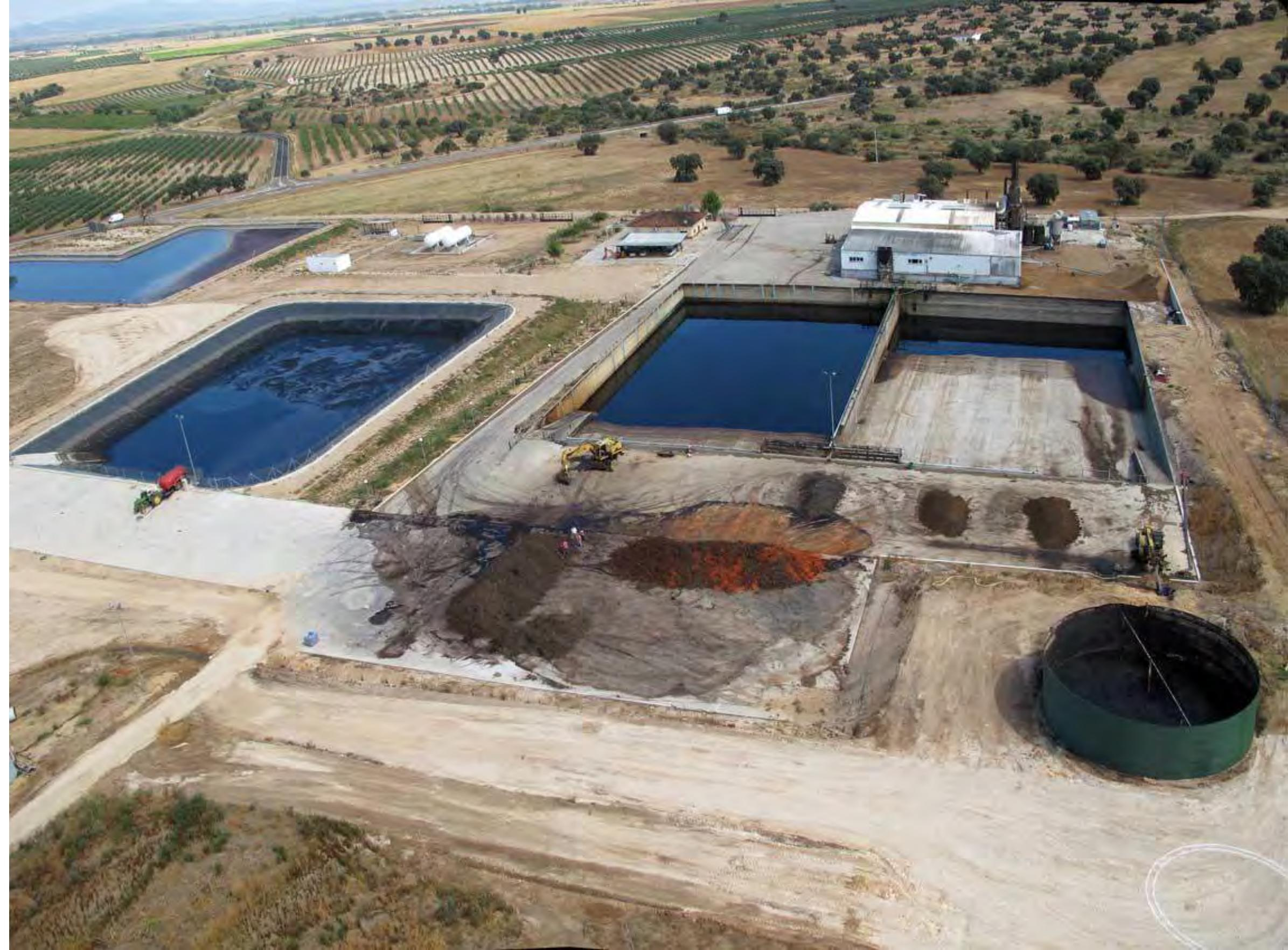
El vaciado de las balsas de almacenamiento a la balsa pulmón se realiza a través de un sistema de compuertas a distinto nivel.
