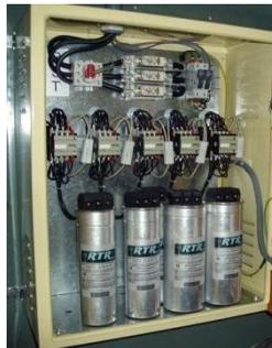
Figura 6.2. Condensadores para compensación de energía reactiva
