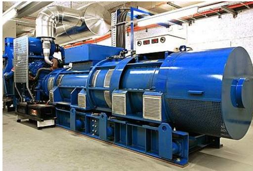
Figura 6.8 Equipo generador de alimentación ininterrumpida
