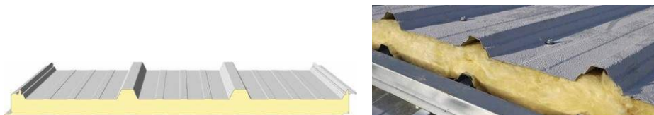
Figura 5.1. Cubierta tipo Sandwich. Prefabricado (izquierda). In situ (derecha).
